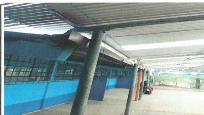
Foto 3: Instalación de canales.
