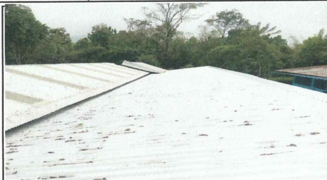
Foto 1: Entechado nuevo en aulas
