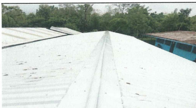
Foto 4: entechado nuevo en aulas.
