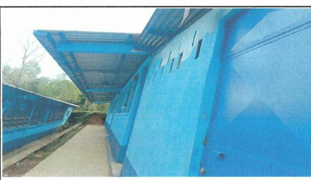
Foto 4: Mantenimiento de pintura en paredes.
