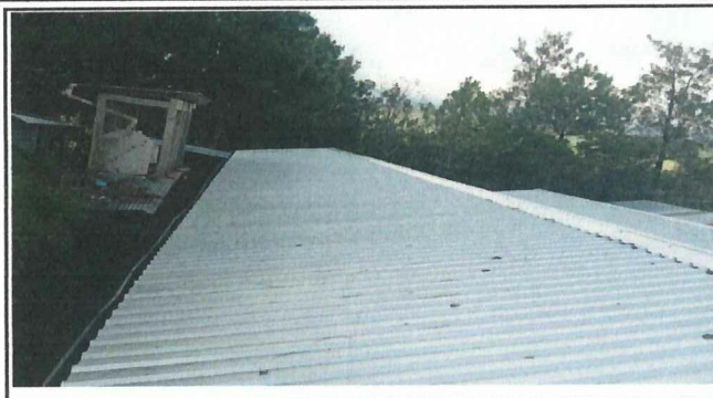
Foto 2: entechado nuevo en aulas.
