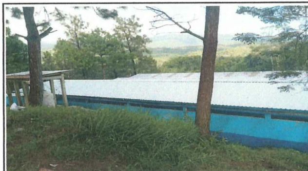
Foto 4: entechado nuevo en aulas.
